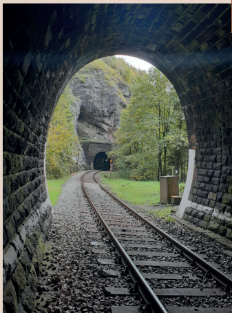
Tunel - Horná Štubňa
