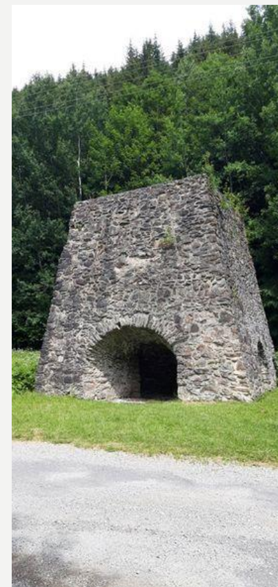
Vysoká pec Tri Vody
