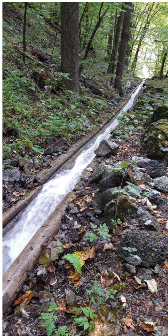
Vodný žľab Rakytovo, Dolný Harmanec. Zrekonštruovaná technická pamiatka na splavovanie dreva. Foto: autor
